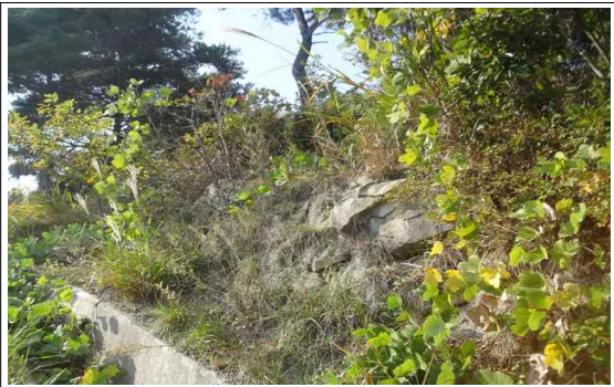
사면(중점부) STA.0+5 자연사면 벌목적치
