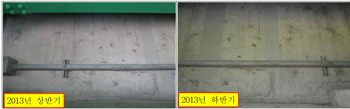
하행선 A2 홍벽 균열 보수 현황
