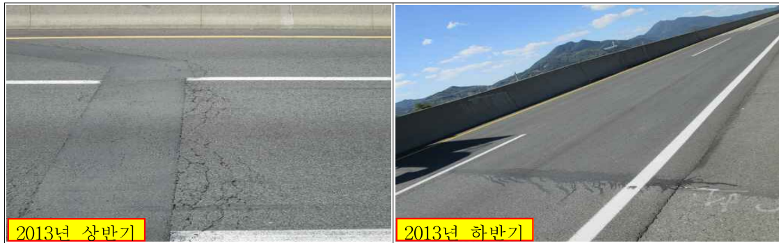
상행선 A1측 접속도로 구간 포장면 보수부 밀림 보수 전·후 현황
