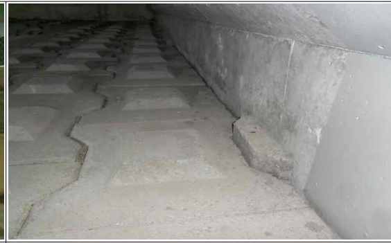
하행선 A1 법면 법면 접합부 이격 및 침하
