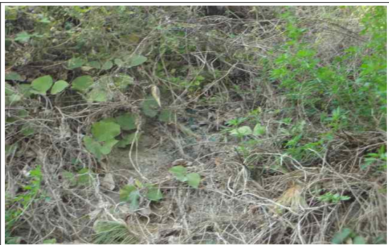
사면(시점부) STA.0-20 1단 녹생토유실
