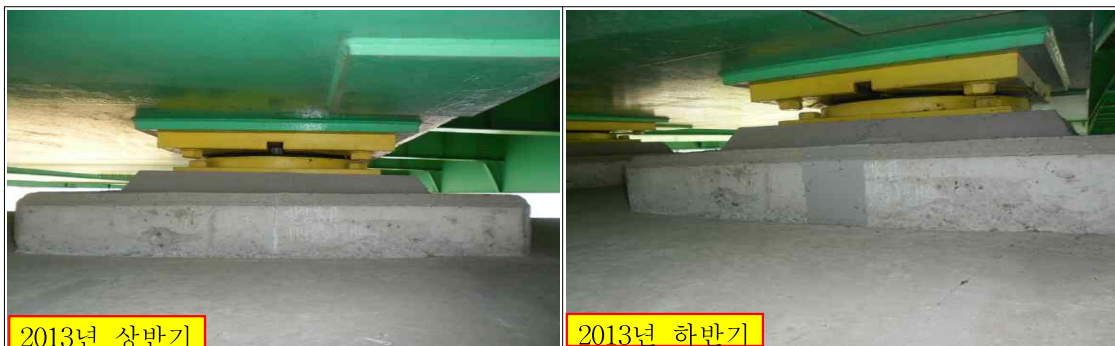
상행선 P14 SH2 받침콘크리트 균열 보수 전·후 현황
