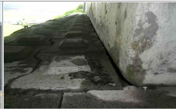
하행선 A2 법면 법면 접합부 이격 및 침하
