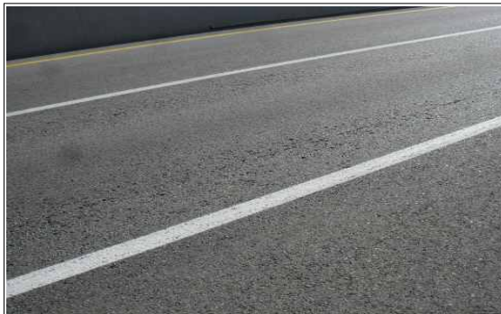
하행선 S2측 교면포장 라벨링
