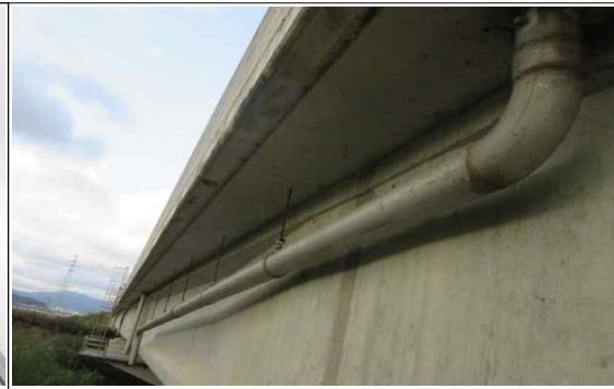
하행선 배수관 전경
