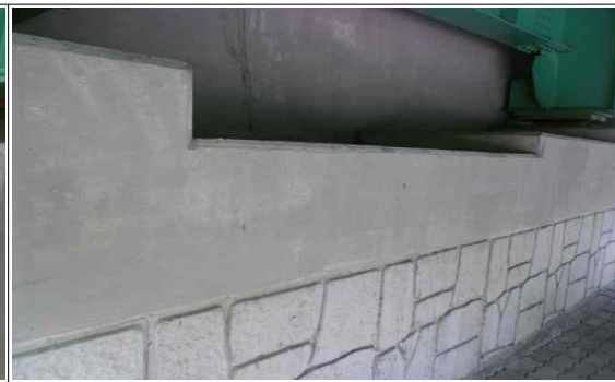
하행선 A2 균열 보수 현황
