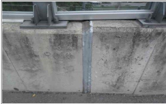
상행선 A2측 접속도로 방호벽 단차 및 실란트 파손 보수현황
